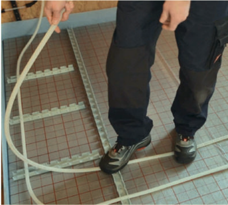
Schienenverlegung
